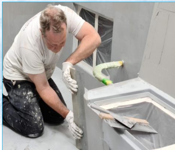
Het casco wordt diverse malen geplamuurd.
